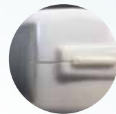
Riss im Sondengehäuse
